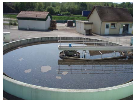
La station d'épuration de Vendevre sur Barse
